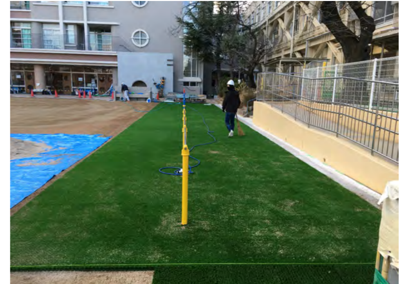
散水仕上途中
