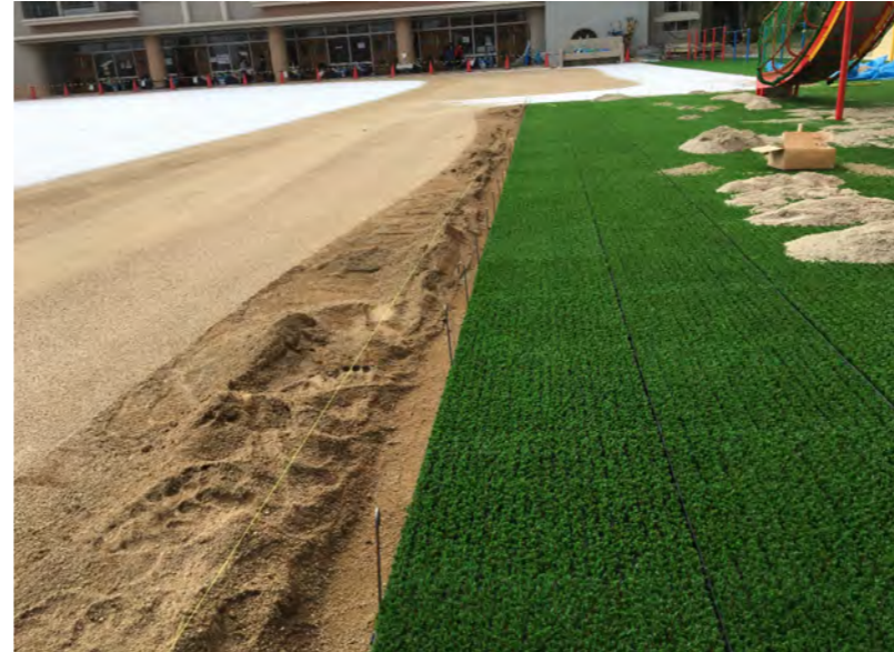
クイ打ち作業(外周のみ)
