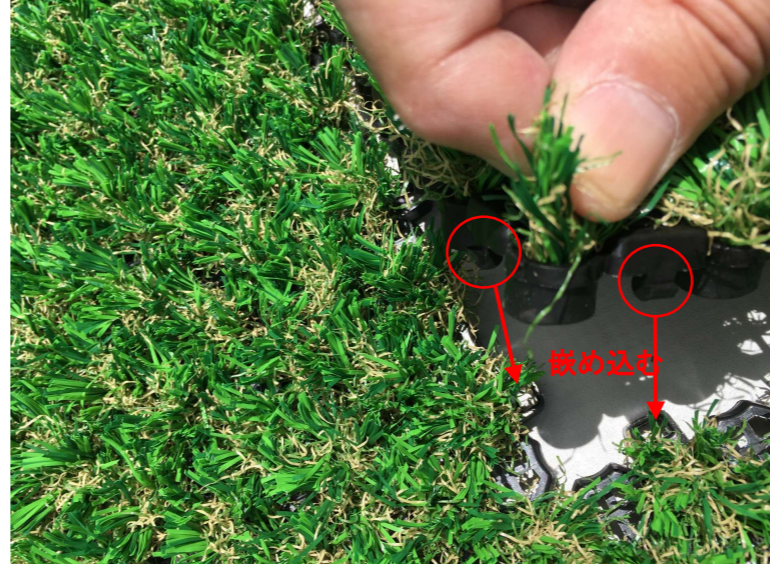
ジョイント部分をはめ込みます
