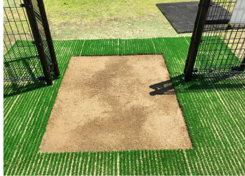
真砂土地盤を不陸調整して締め固めます
