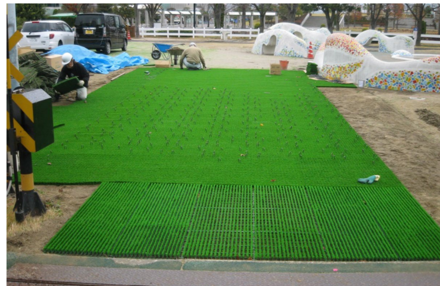
アンカー打込み完了後に目砂を充填する
