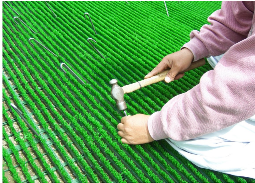
④アンカークイを打ち終わったら砂を入れる
