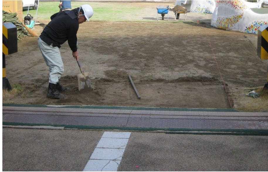
下地整地 (GLより3cm鋤取り整地)
