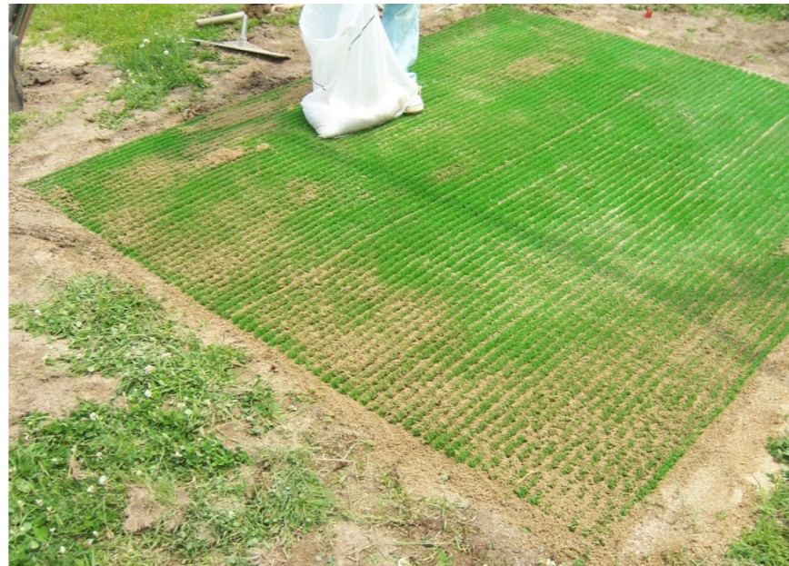
散水する（砂を締める・芝を開かせる）
