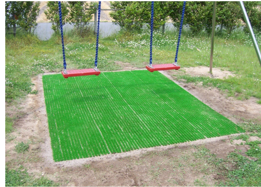
散水する（砂を締める・芝を開かせる）
