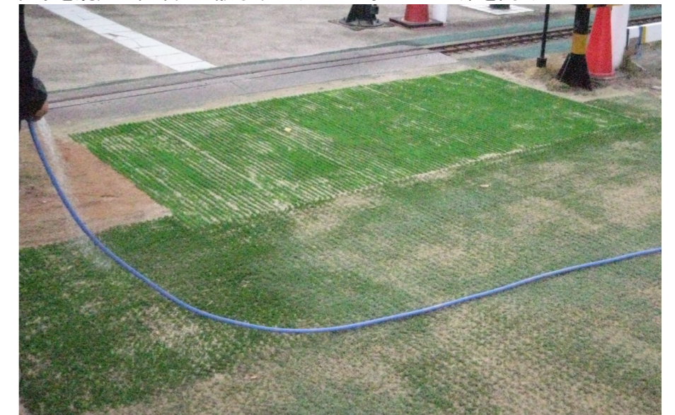
目砂を規定量充填して散水する (レーキ等で叩いて葉を開く)
