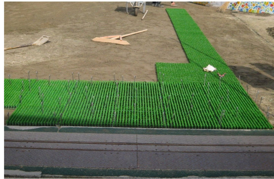
アンカー杭打ち (規定本数を並べて打ち込む)
