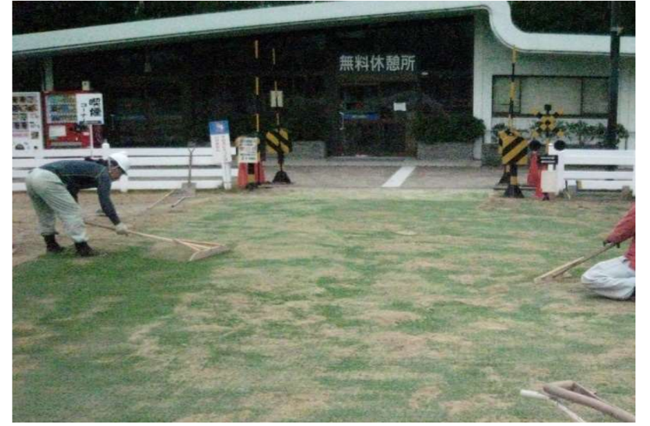
目砂を充填後に散水しながらレーキ等で叩いて葉を開く
