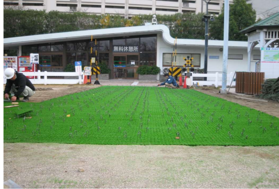
アンカー打込み完了
