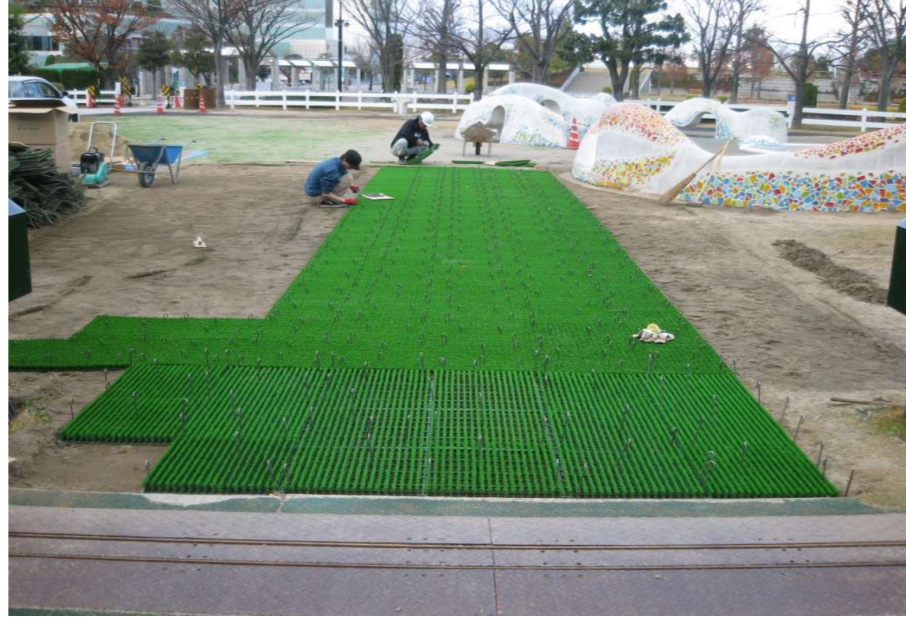
整地・敷設・アンカー仮打ち
