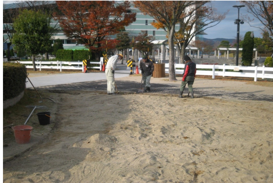
レーキ等で整地後に散水をして転圧をかける
