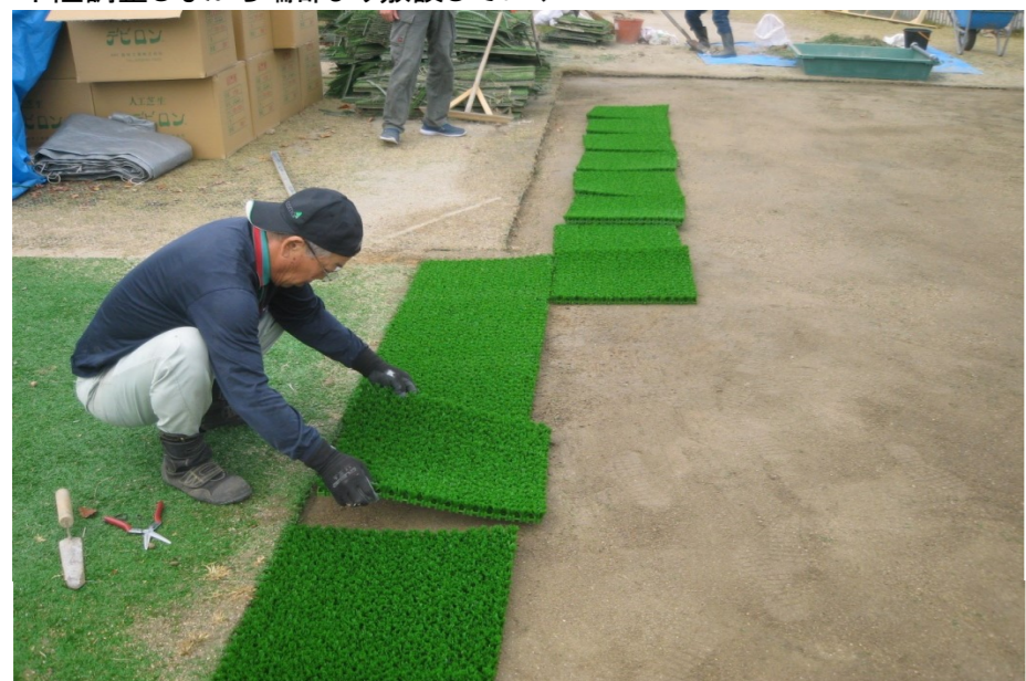
不陸調整しながら端部より敷設していく
