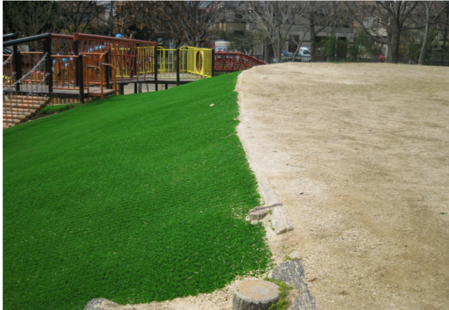
法面天端 流土防止の見切り材(丸太材)
