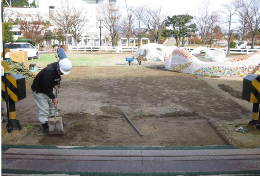
整地・鋤取り(#106はGLより20mm鋤取る)
