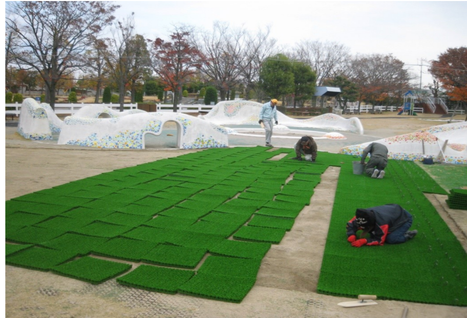
アンカー仮打ち作業
